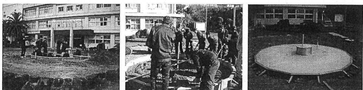
次に車体設置場所の基礎工事についてです。コンクリートの型枠は機械科3年生が製作し、型枠設置と生コンを入れる作業は機械科2年生で行いました。学年を超えた連携がいい感じです。コンクリートの養生を待つ間、車体展示が待ち遠しいですね。
