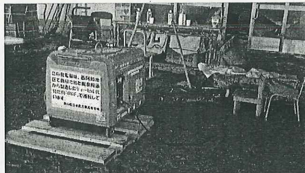
被災地に BDF 発電機を提供
